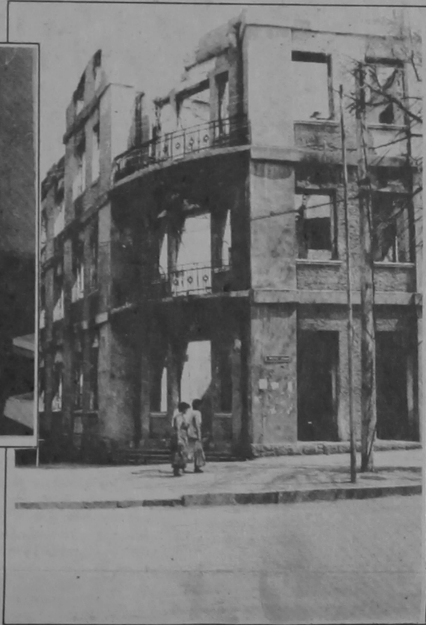
Destrozos en importante edificio de Stepanakert capital de Karabagh
